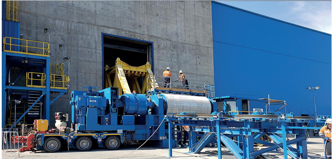
Подготовка к навеске канатов: мобильная фрикционная лебедка перед машинным залом; на переднем плане – горизонтальные отклоняющие шкивы.
