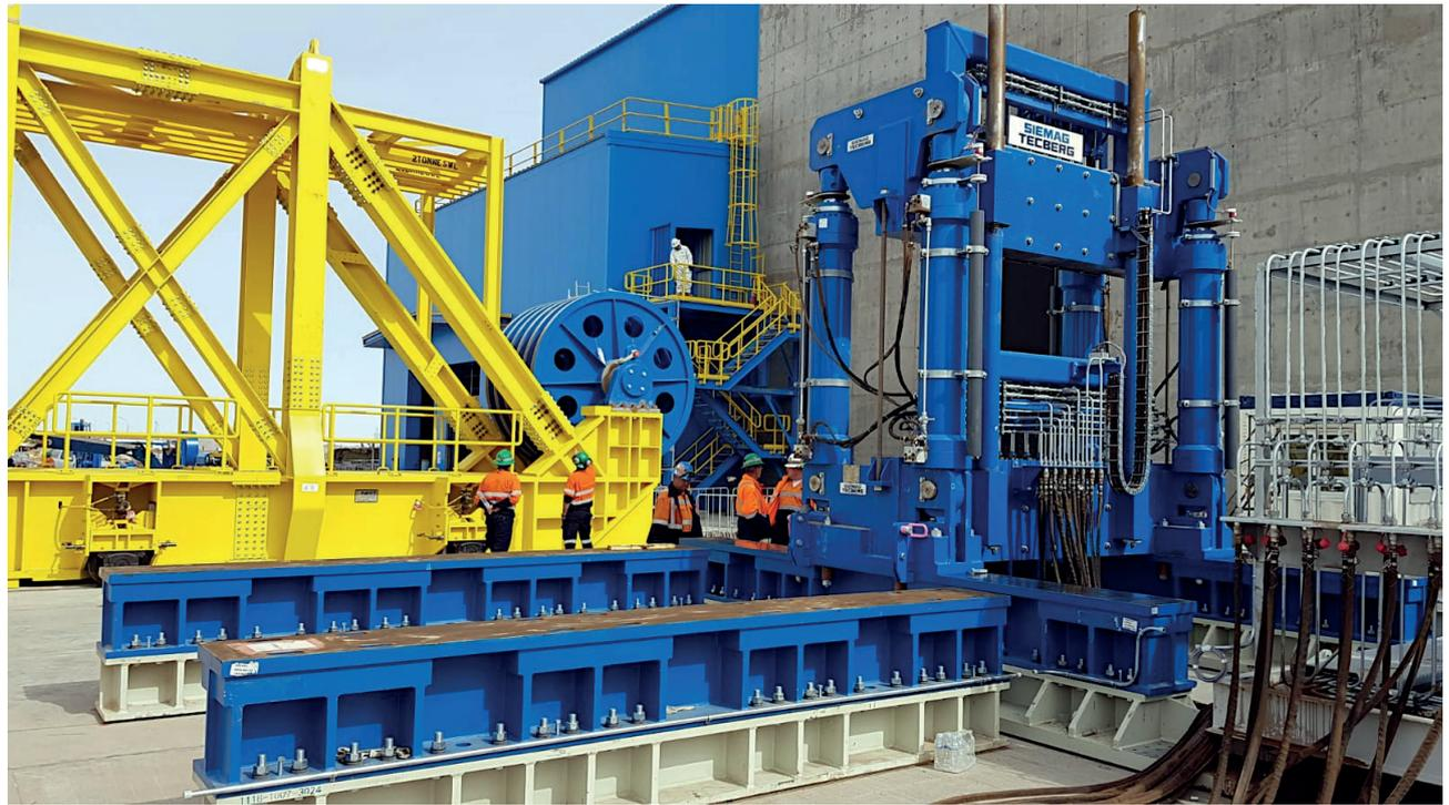
Подготовка к навеске канатов: установка и функциональные испытания оборудования. Справа на фото: 6-канатное подъемно-зажимное устройство с гидравлической системой.
