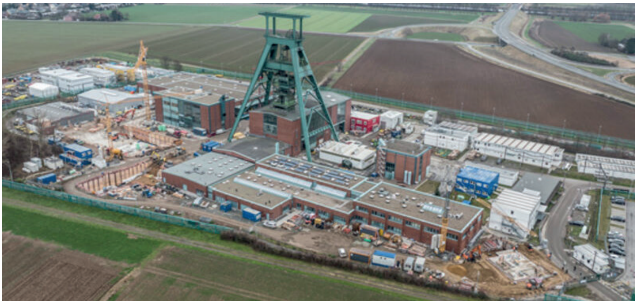
Bild 5 Copyright 2022 BGE: Schachtanlage Konrad 1 aus der Luft. Links im Bild sind die Bauarbeiten am Gebäude für die neue Werkstatt zu erkennen. Bildnutzung mit freundlicher Genehmigung der Bundesgesellschaft für Endlagerung (BGE).
