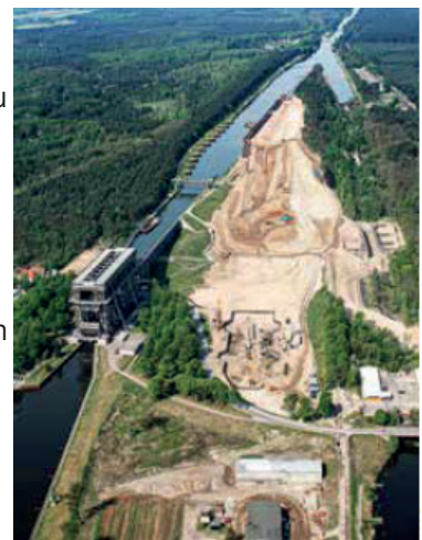
Herstellung der Baugrube neben historischem Hebewerk (© WNA)
