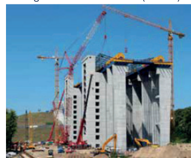
Einbau eines Elements der Seilrollenhalle (© WNA)
