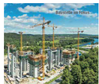
Montage der Stahlbetonbauten (© WNA)
